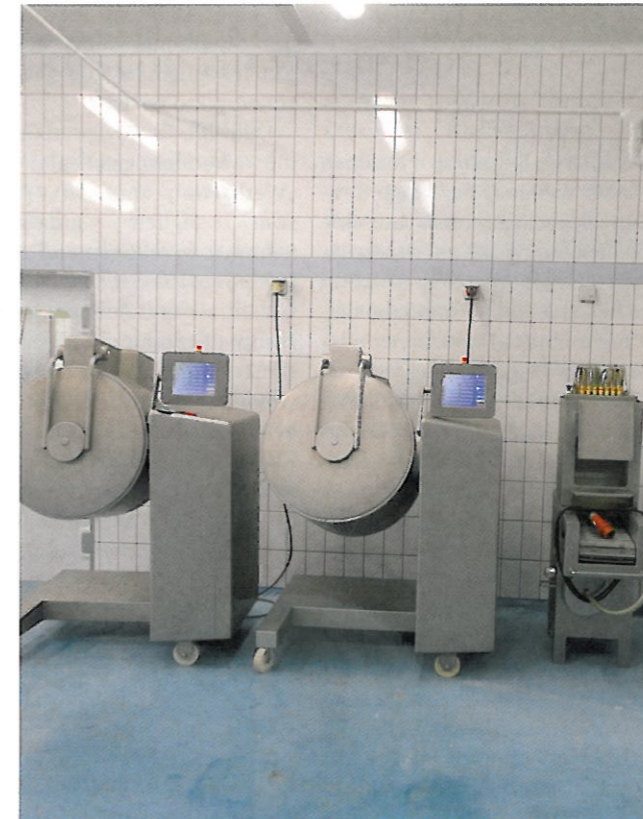
Das Verlegen neuer Leitungen muss auch bei Maschinenpark-Erweiterungen immer möglich sein
