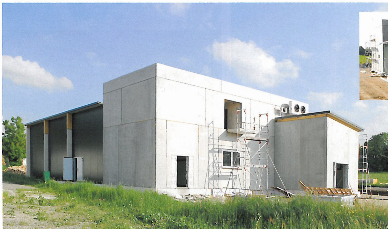
Massiv: Wartestall, Schlachtung, Räucher- und Kochbereich des Bauprojekts von Jochen Rieck wurden als stark beanspruchte Bereiche mit Betonsandwichwänden und -decken gestaltet.
