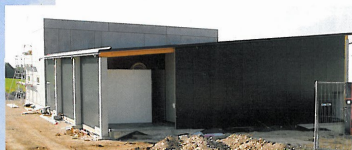
Leicht: Für Zerlegung, Wurstproduktion, Kühlräume und Auslieferung reicht die wirtschaftlich sinnvolle Verwendung von Stahl oder Stahlbeton-Fertigteilstützen aus. Fotos: Michael Wirth
